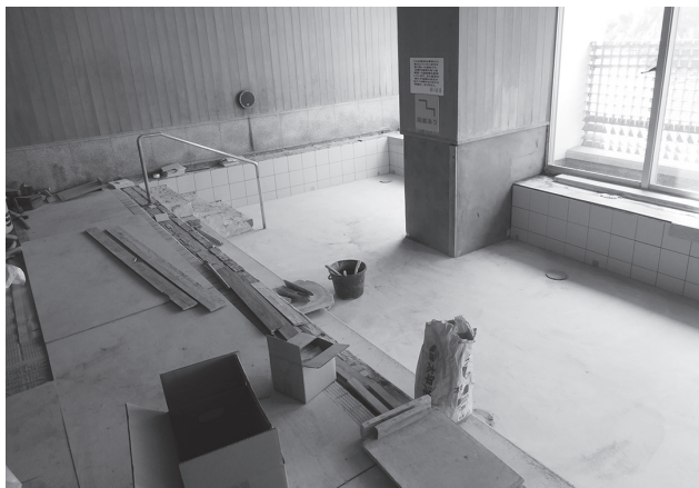
改修工事が進む鳩子の湯
