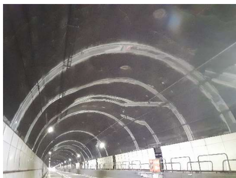
写真 3-2 導水桶工設置状況（他トンネルの事例）
