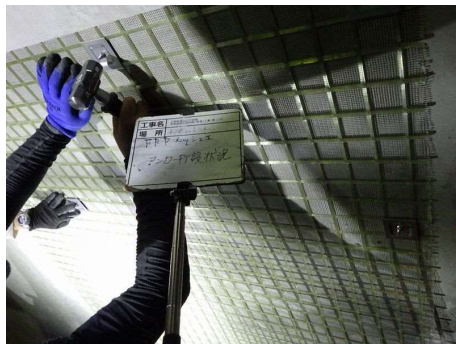
写真 3-1 FRP ネット設置状況（他トンネルの事例）
