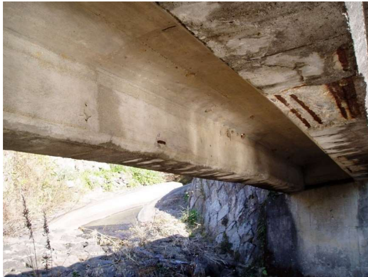
志田6号橋 上部構造(主桁)
