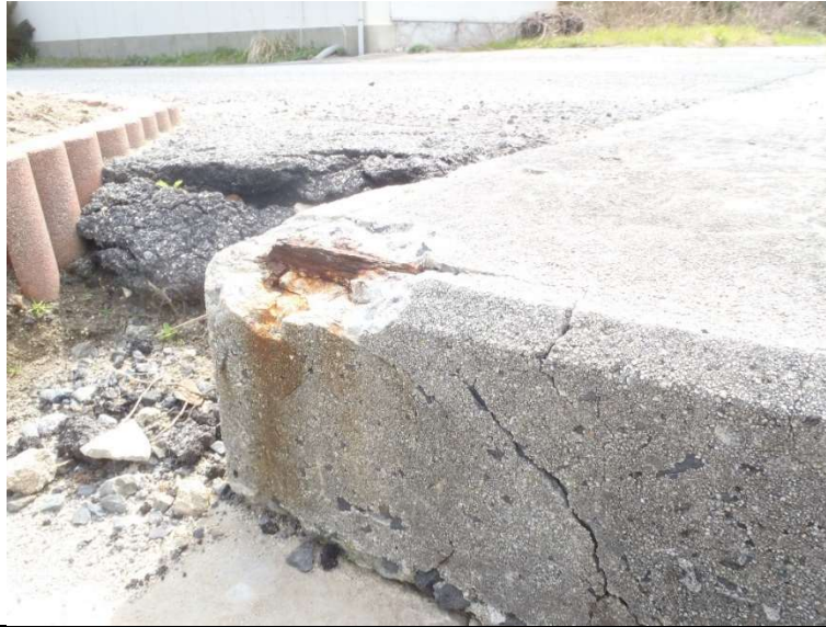
志田7号橋 上部構造(主桁)
