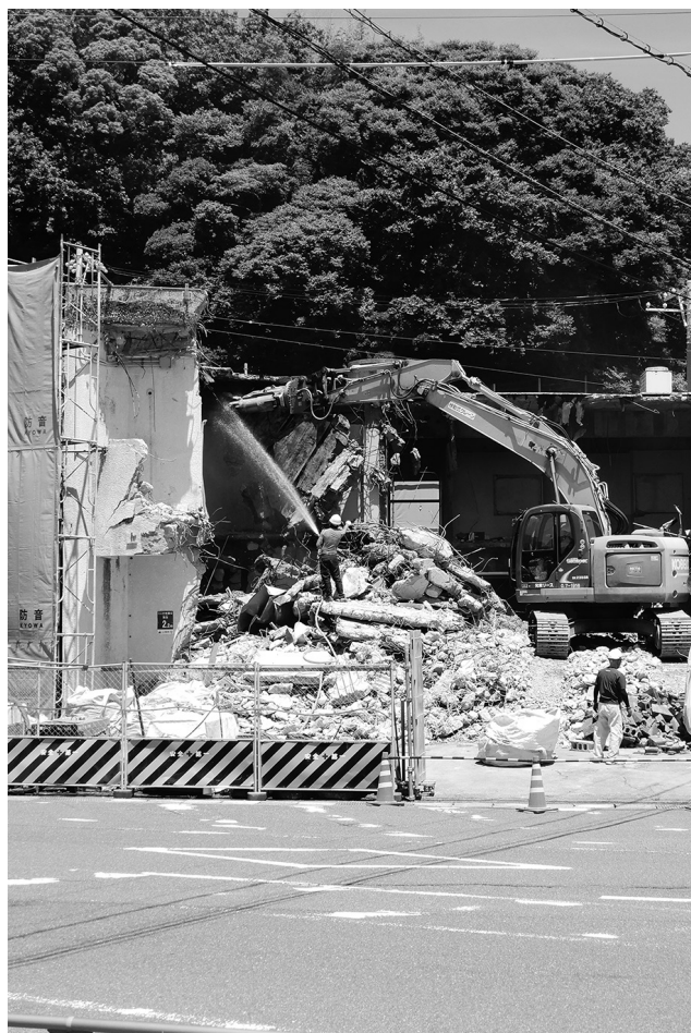
解体中の旧中央公民館
