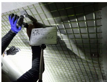
写真 3-1 FRP ネット設置状況（他トンネルの事例）
