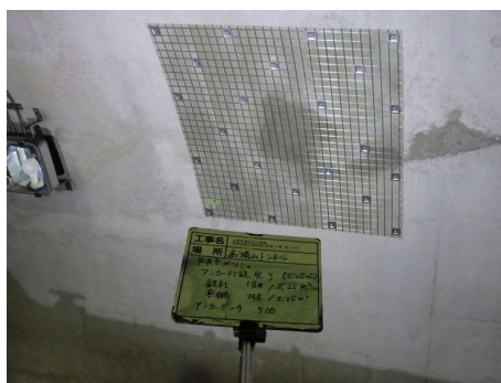
写真 3-1 FRP ネット設置状況（他トンネルの事例）
