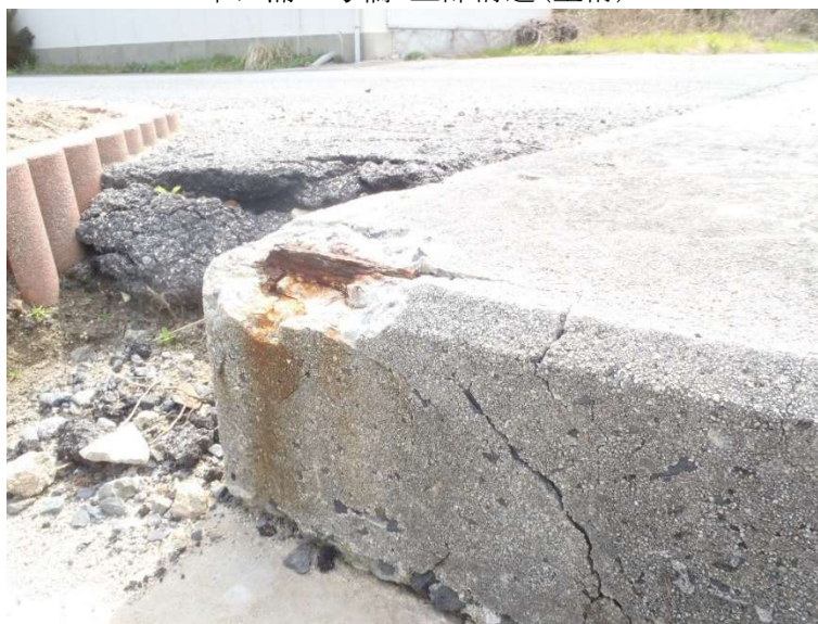
志田7号橋 上部構造(主桁)
