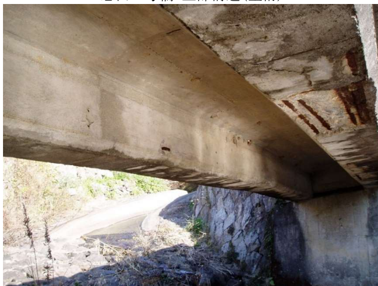
志田6号橋 上部構造(主桁)
