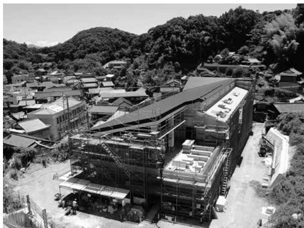
建設工事（2021年7月頃）
