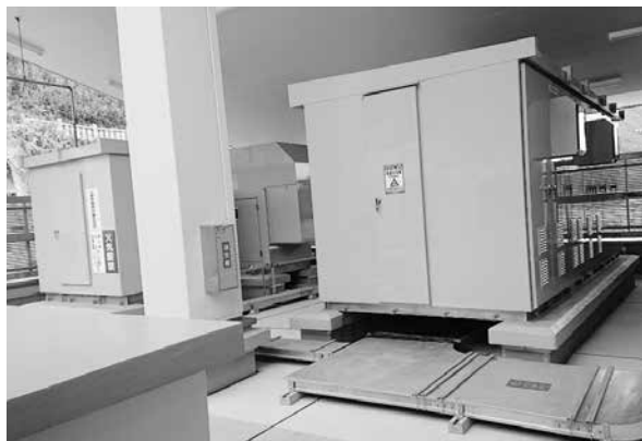
自家発電設備
