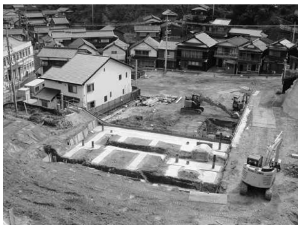
基礎工事（2020年10月頃）
