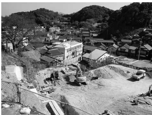
造成工事（2019年10月頃）
