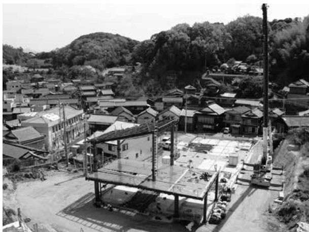
建設工事（2021年4月頃）
