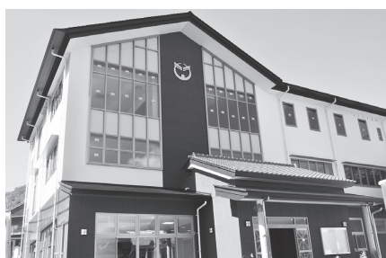
完成した庁舎
