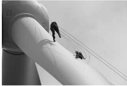
ロープを下りながらの点検作業
