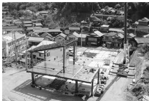
▲ 建設が進む新庁舎
