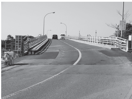
3月26日に規制解除された上関大橋
