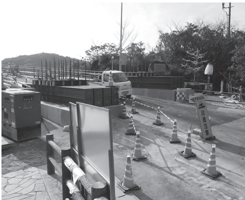
応急工事が進む上関大橋
