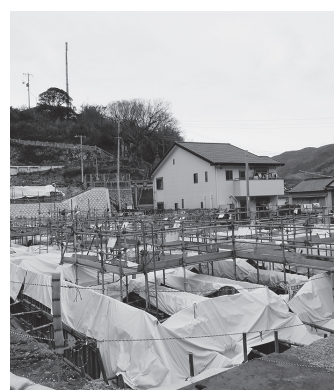
新庁舎の工事現場
