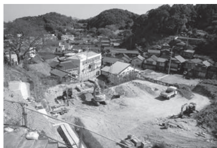
▲新庁舎建設工事
