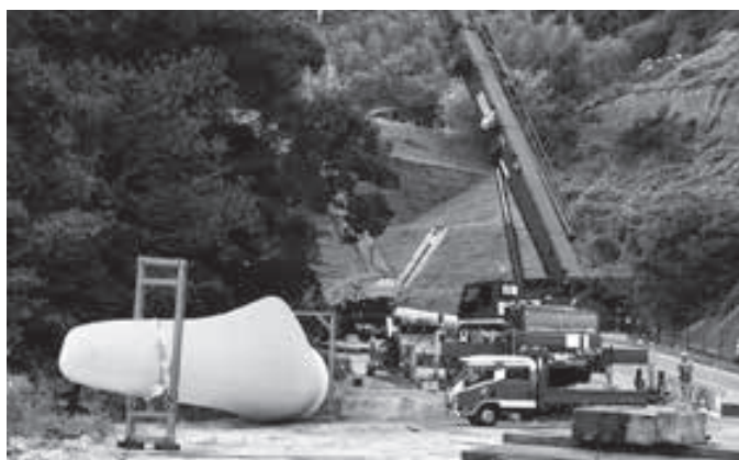
風力発電、仮置き場の様子
