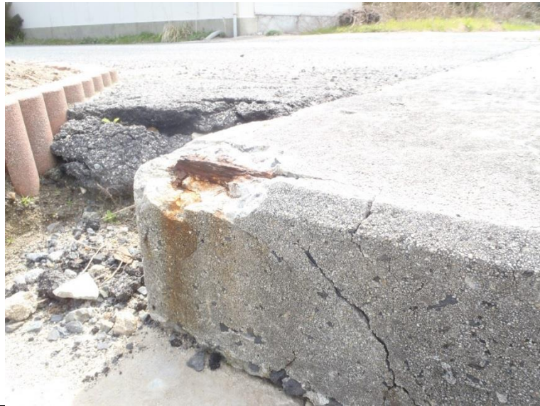
24_志田7号橋 上部構造(主桁)
