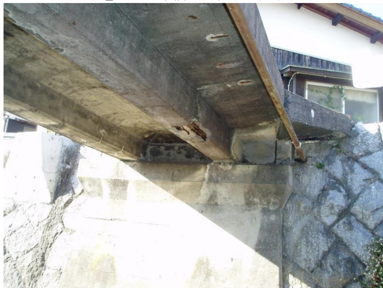
図 1. 2. 3 主な損傷写真-1
