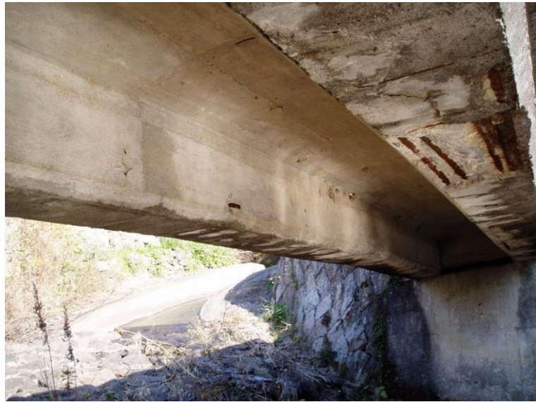
27_志田6号橋 上部構造(主桁)
