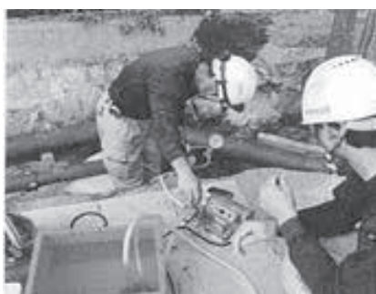
上関～四代線送水管布設替え
