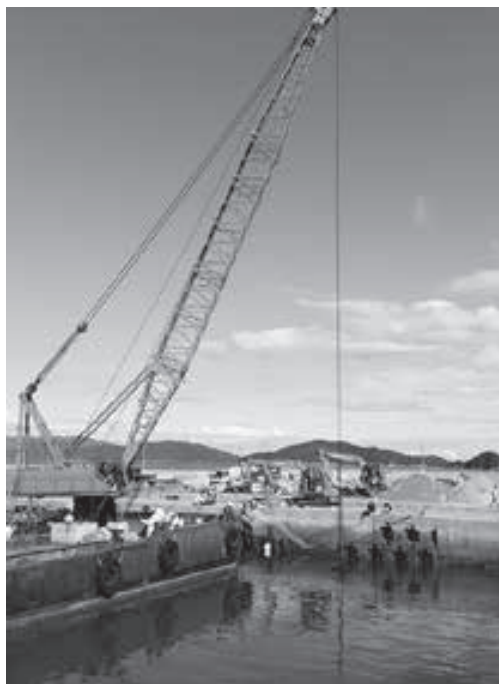
浮桟橋設置工事開始（祝島）
