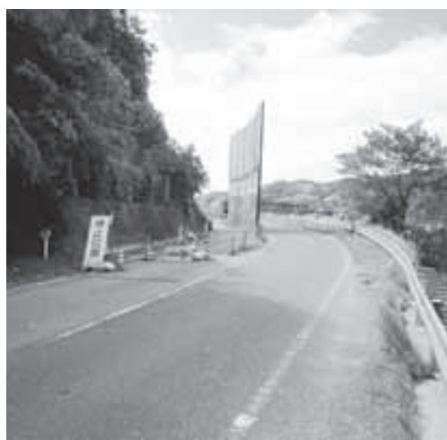
災害復旧工事（室津地区県道）
