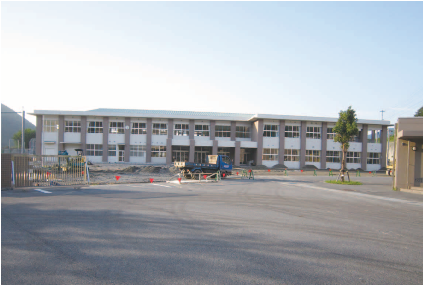
外構工事が進む上関中学校新校舎
