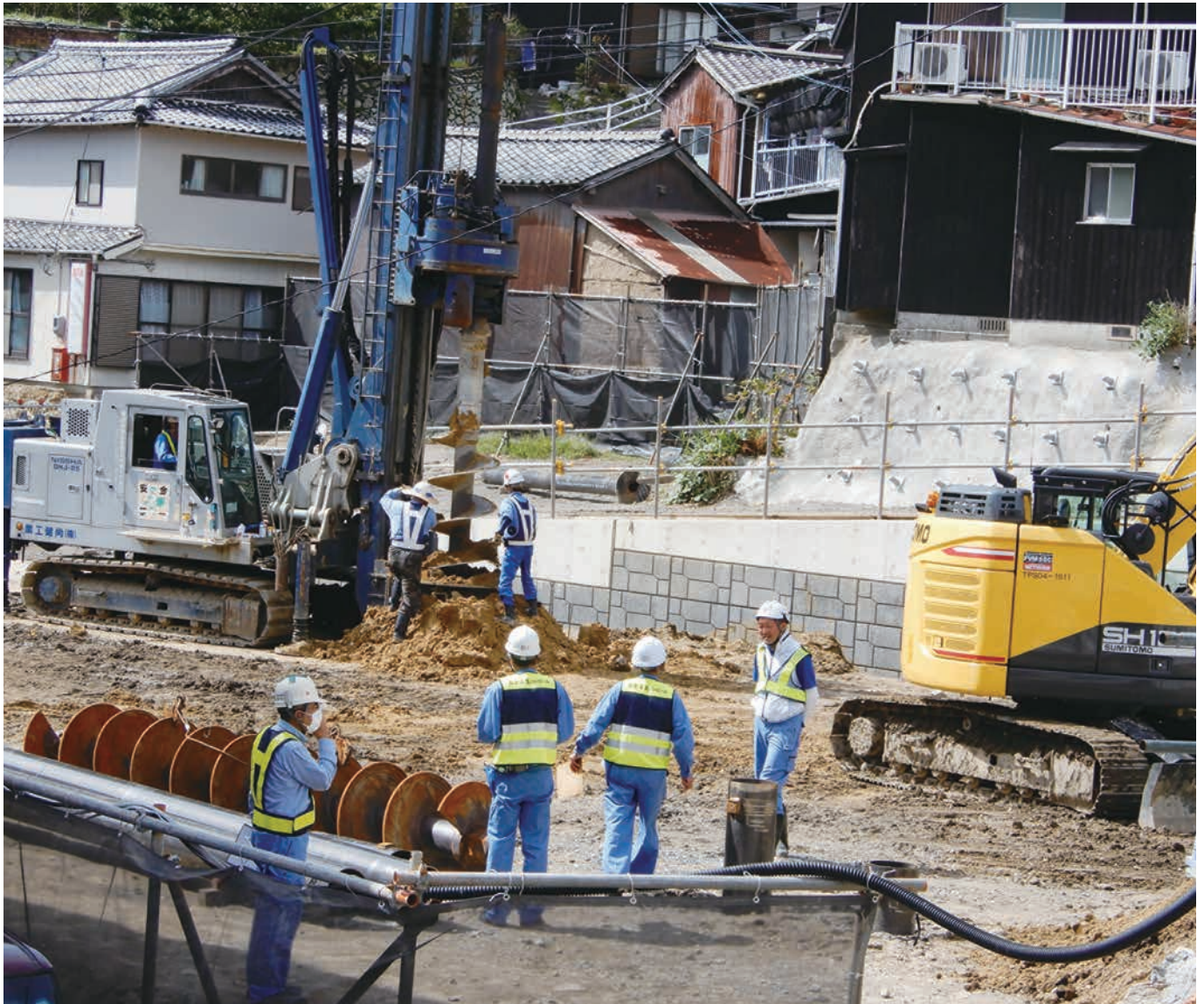
新庁舎の工事現場
