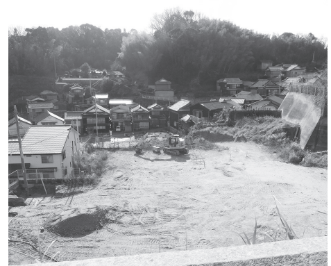
新庁舎建設地
