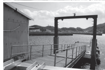
▲新しく建設される 室津航路待合所と室津浮棧橋
