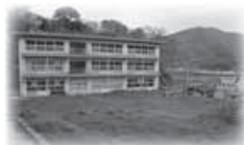
▲解体する旧上関小学校
