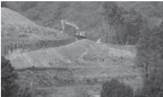
上盛山町道拡幅工事
