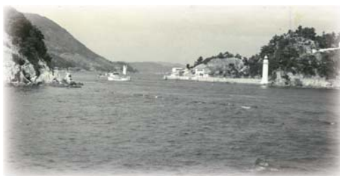
架橋前の上関海峡。
