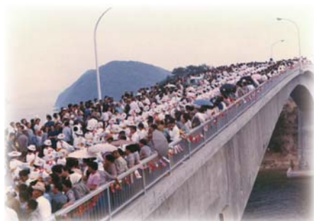
上関大橋の開通式。人で橋が落ちそう？
