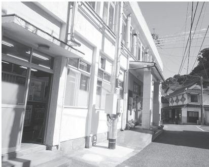
老朽化した庁舎
