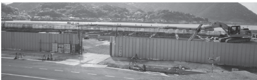
建設中のふるさと市場と総合文化センター
