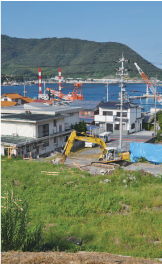
室津地区町営住宅団地造成工事
