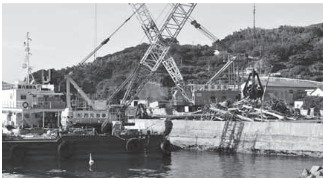
九州北部豪雨の流木回収（室津旧フェリー基地）
