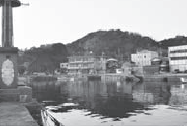
整備が進む上関本港
