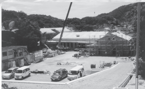
上関海峡温泉建設現場
