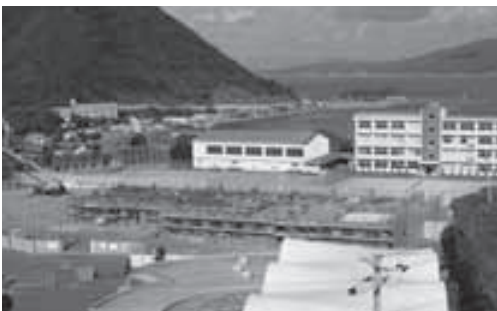
▲中学校建設工事着工
