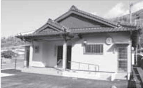
▲「四季の里 志田」竣工
